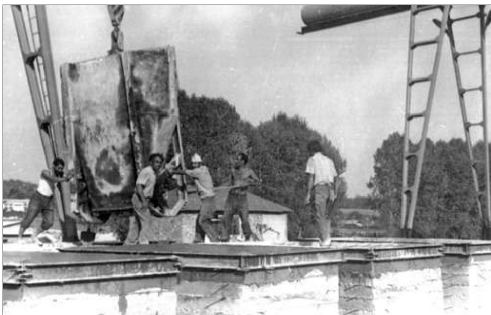
Едропанелно жилищно строителство (ЕПЖС)
