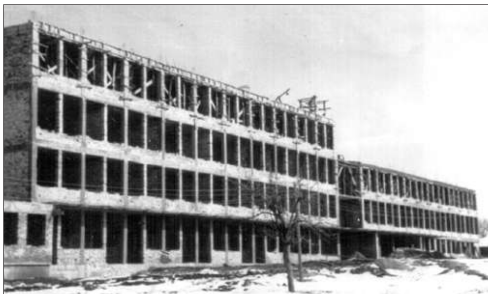
Строителство на жилищен блок в града, 1969 г.
