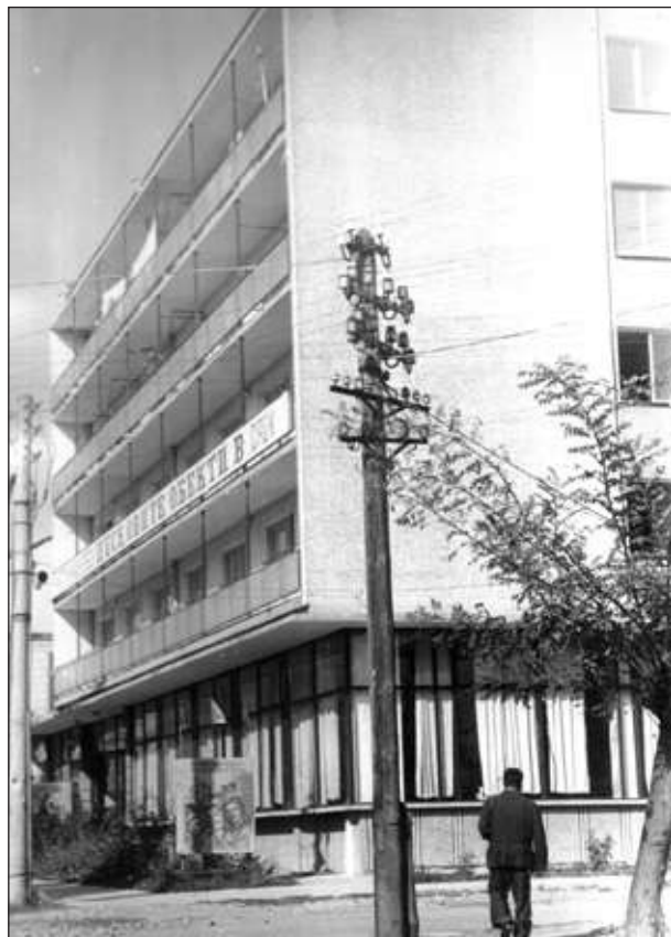
Административната сграда на Строителното предприятие
